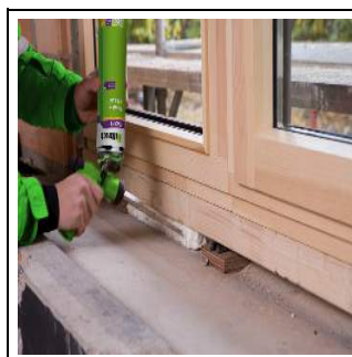
2. Bild: Verarbeitung der Fensteranschlussschneidung mit FM220.
