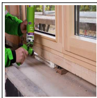
2.Bild: Verarbeitung der Fensteranschlussfuge mit FM220.
