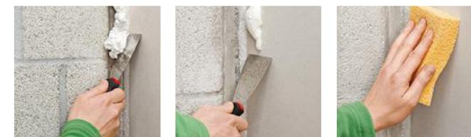
**4** JF100 mit einem Spachtel von unten nach oben glätten, nicht abziehen. Reste mit einem Spachtel entfernen und Oberflächen mit einem nassem Schwamm reinigen.
