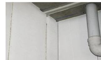
Fugen zwischen Trockenbauwänden und an Rohren.
