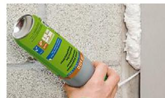
Fugen zwischen Innenwänden von Kalksandstein, Porenbeton und / oder Metallbolzen.
